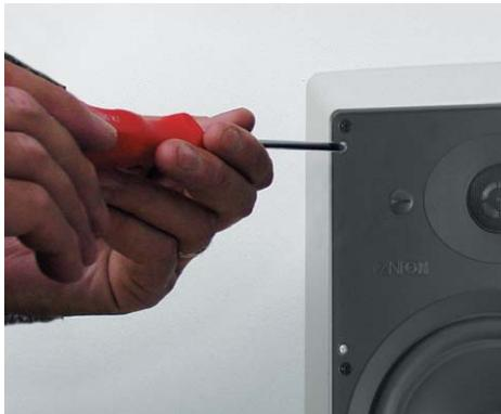
Nach dem Einsetzen wird das InWall System jeweils an den **silbernen Schrauben** in der Wand fixiert.
